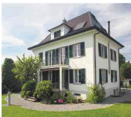
Nach der erfolgreichen Fensterlädenrenovation erstrahlen die Objekte in neuem Glanz.
